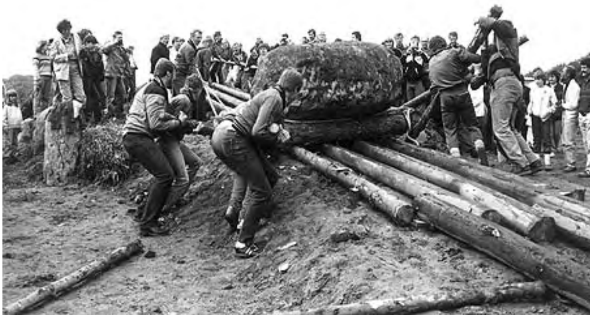
Takblocket till långdösen i Skånes Djurpark förs på plats med till synes enkla redskap. Foto Nils Björhem.
